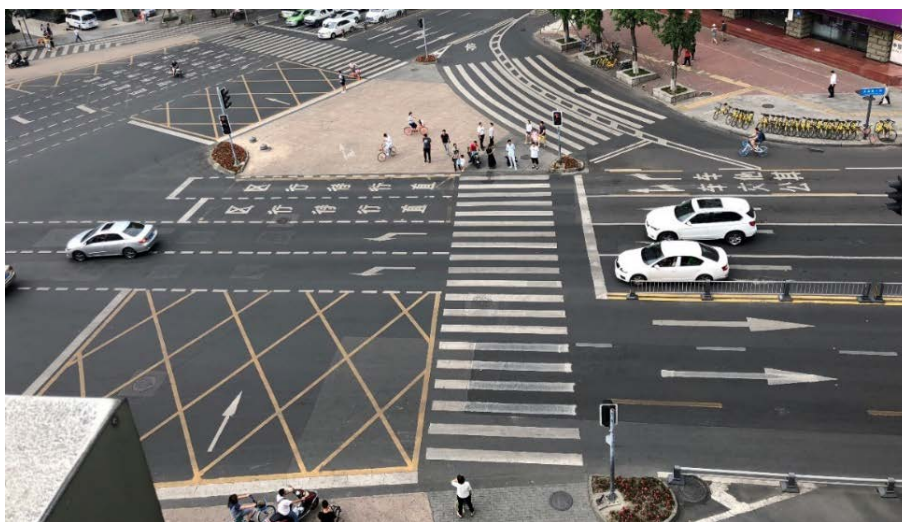
图 3.19 东城根下街南进口行人过街处
