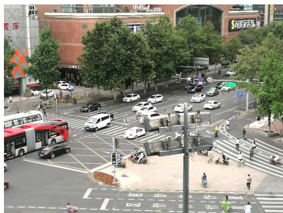
图 3.14 交叉口交通标线实景图
